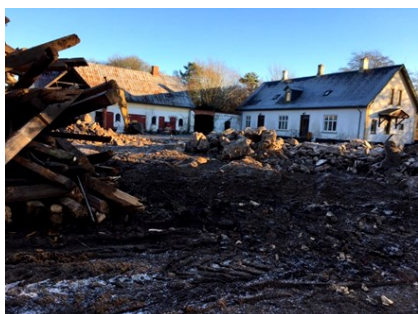
Efter nedrivning af to længere
