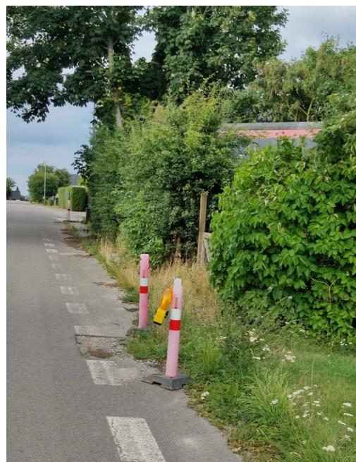
Arbejdet på Udbyvej og Kirkemosevej har stået ufærdigt i længere tid.
