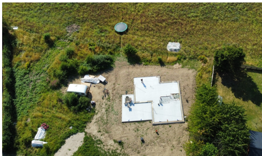
Mads har investeret i en drone for bl.a. at dokumentere byggeriet. Her er byggepladsen og lidt af marken i juli.
