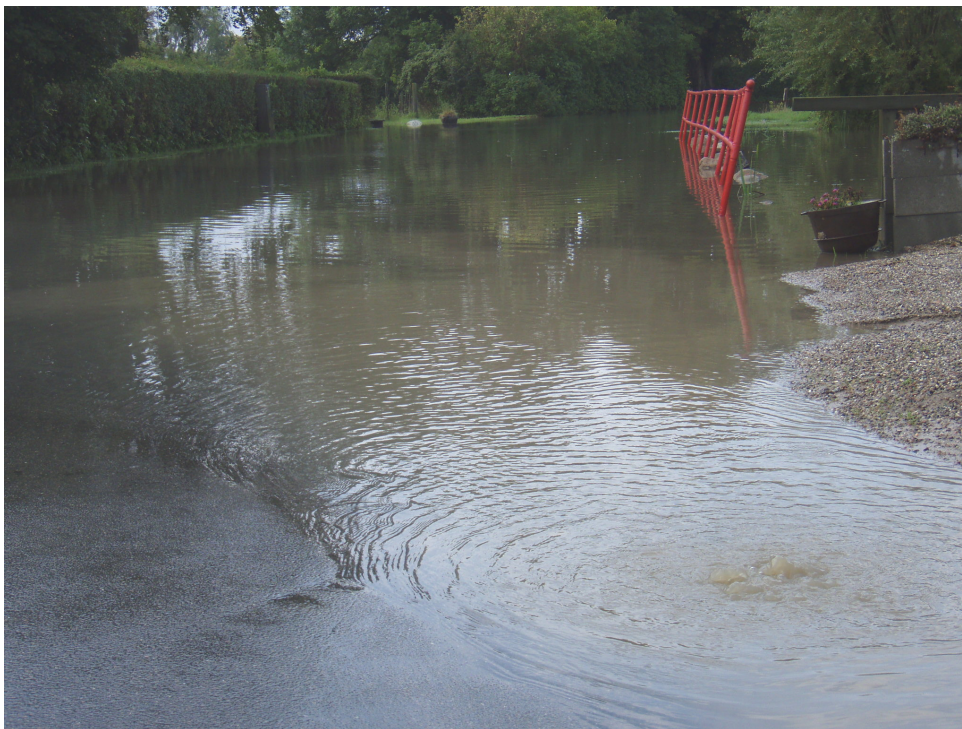
Gadekær og Udbygade som sø den 27. august 2011 efter skybrud med 25 mm nedbør + 10 mm regn på 8 timer.
